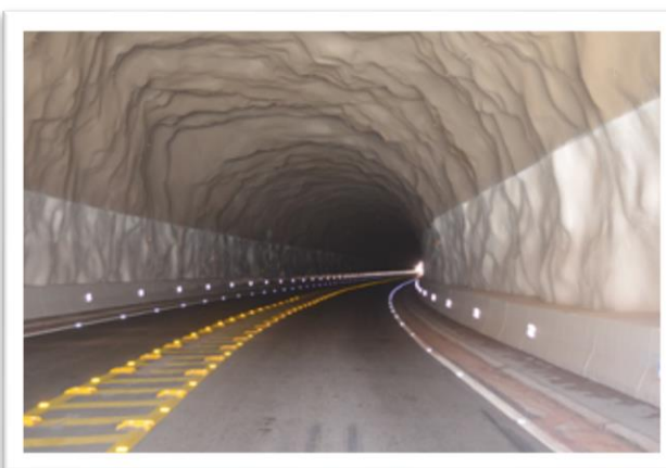
Interior de uno de los túneles en curva - RN N150
