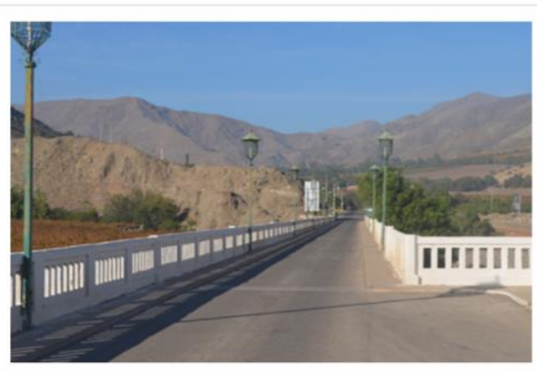
Puente de ingreso a la Localidad de Vicuña Vista hacia la Ruta CH 41
